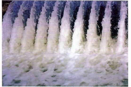
工作状态中的 LBP-1400A(B) 转碟
